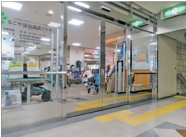
入口の点字ブロック
