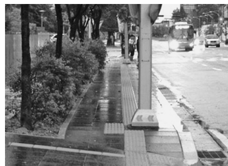
（写真：韓国、点字ブロック現状）
